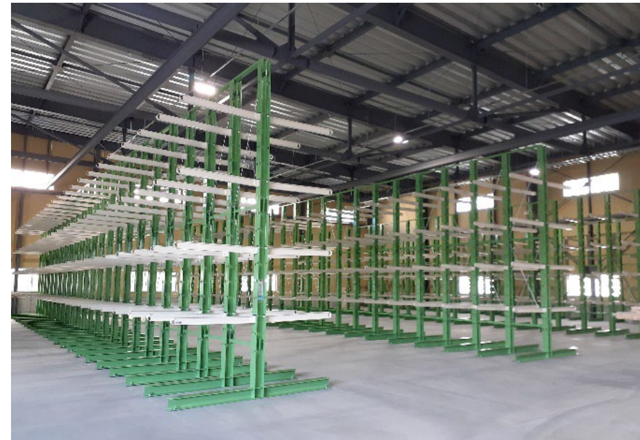
新設倉庫内の木材をアイテム別に保管するラック
