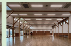
松島めぐみの森 (宮城県松島町) 10m超の大スパンに S WOOD BEAM MOREを活用
