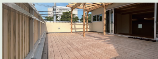
ObiRED®の施工事例(ウッドデッキ)
