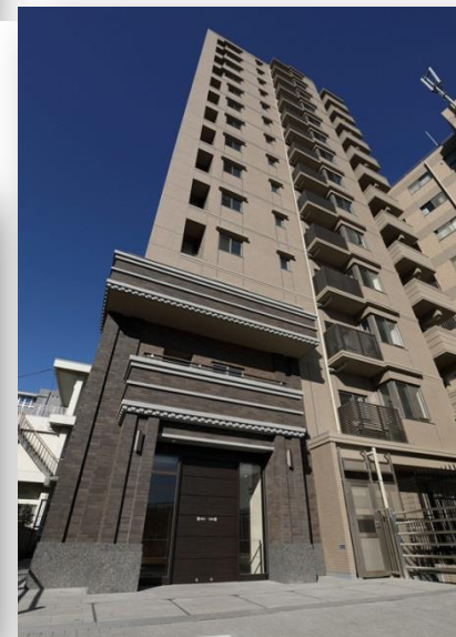
「ノブレス藤沢鶴沼」(神奈川県藤沢市) •総戸数26戸、地上14階建て
