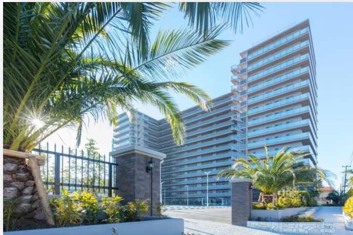
「ノブレス湘南藤沢センタースクエア」(神奈川県藤沢市) •総戸数188戸、地上14階建て
