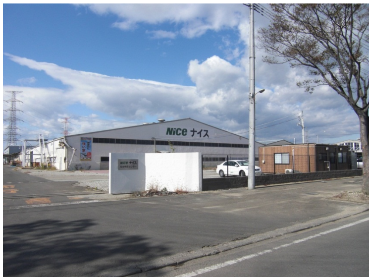
仙台物流センター(宮城県多賀城市)
