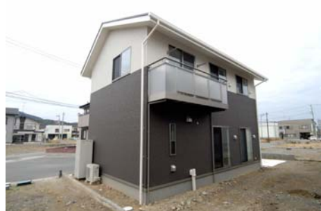
石巻市 建設中物件
