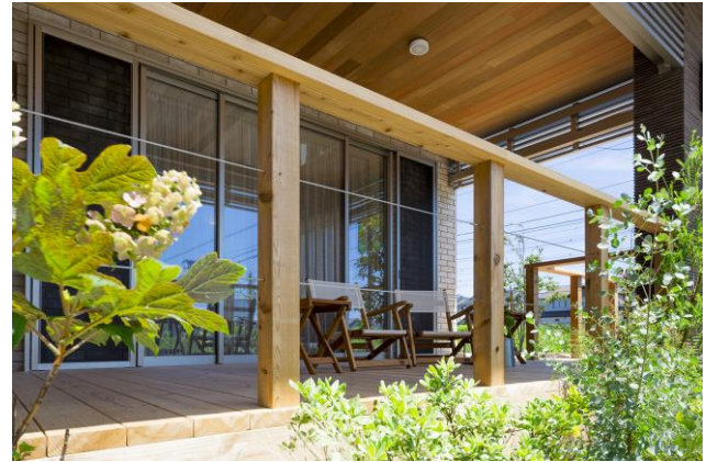
アウトドアリビングとしても使用できる 奥行2.7メートルの おび の 飢肥杉 を使用したウッドデッキ
