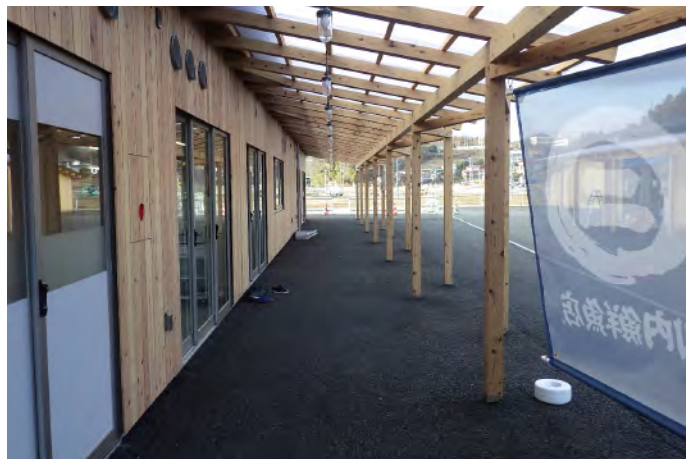
下屋部分に使われているポーチ柱と外壁（南三陸杉）
