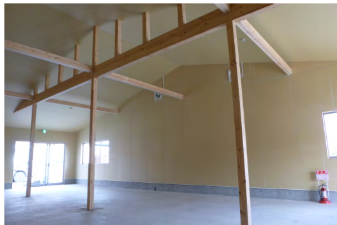
柱や梁が現しとなる店舗内観
