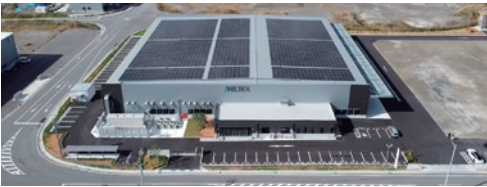
屋根上に太陽光発電システムを搭載した(株)アルボレックスの建材工場
