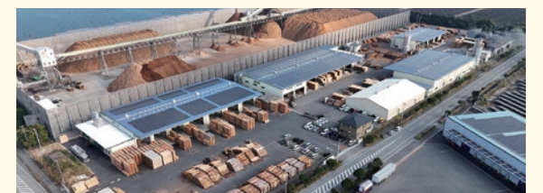
2026年5月から再エネ化した徳島製材工場
