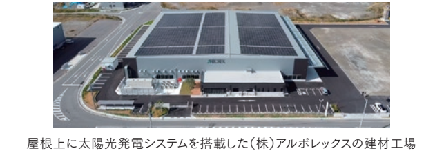
屋根上に太陽光発電システムを搭載した(株)アルボレックスの建材工場
