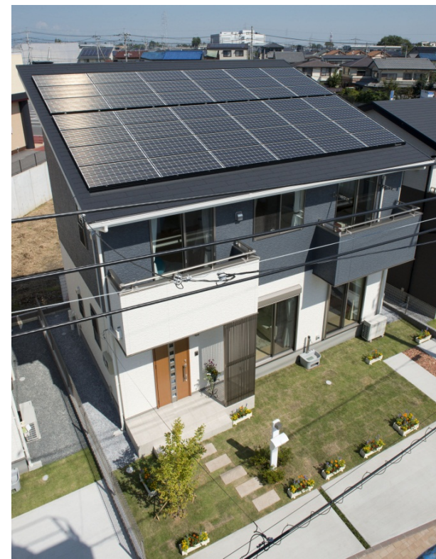
「LCCM(ライフサイクルカーボンマイナス)住宅」 最高ランク★★★★★認定を取得した栃木県 宇都宮市のパワーホーム
