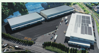
関東物流センター（埼玉県越生町）
