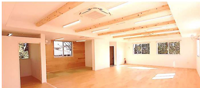
梁を現しとし、天然木のフローリングや豊田市産木材の羽目板をアクセントとして使用した室内空間（画像はイメージ）
