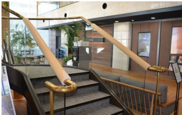
1階ロビーの手摺。下端をU字型に欠き取った磨き丸太を既存の真鍮手摺しんちゆうに上から被せた後、下の隙間を同じ磨き丸太材を使って年輪までそろえた形で埋木をしている
