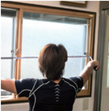
①工事前に現地調査を実施
