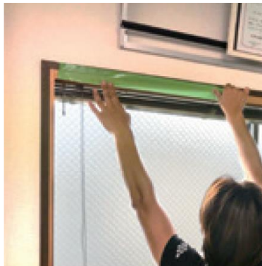
②汚れ防止のために養生
