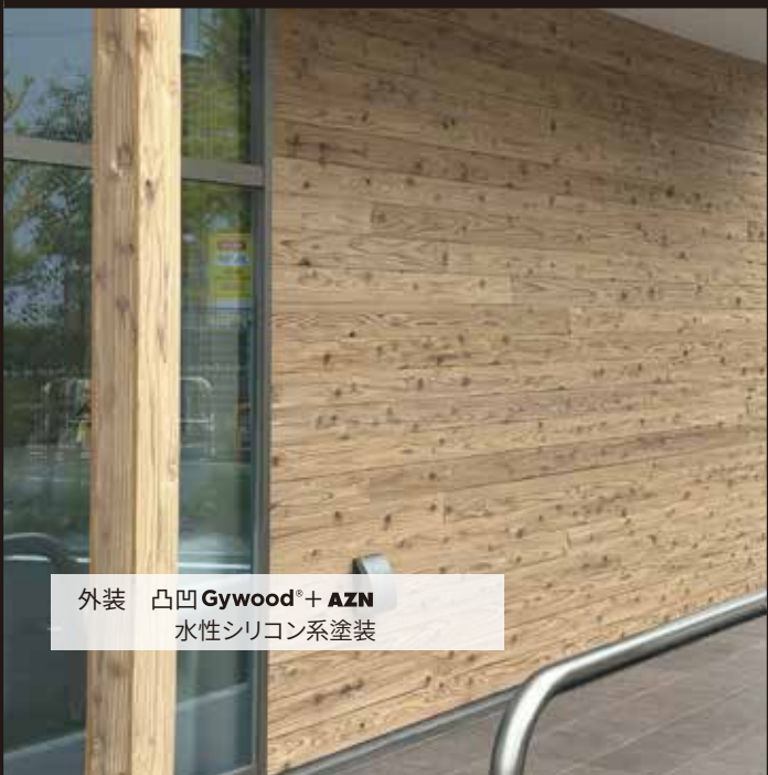
外装 凸凹 Gywood® + AZN 油性含侵系塗装
