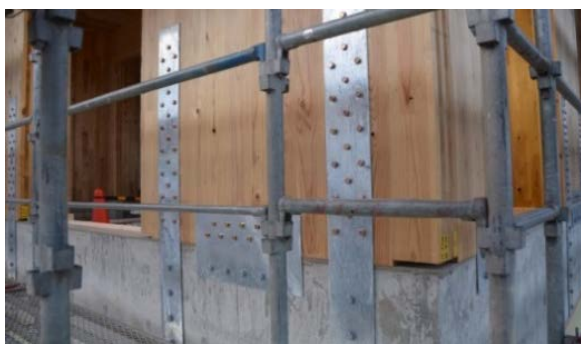
写真④ 基礎とCLTパネルの接合部 (施工中の写真)
